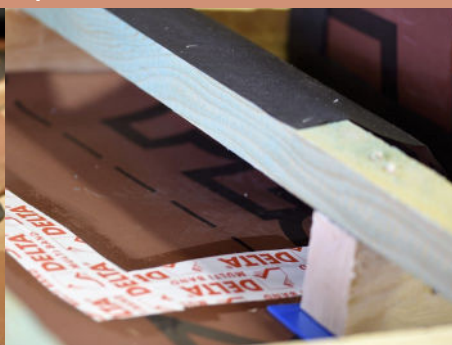
Vytvorenie odvodňovacieho žliabku
